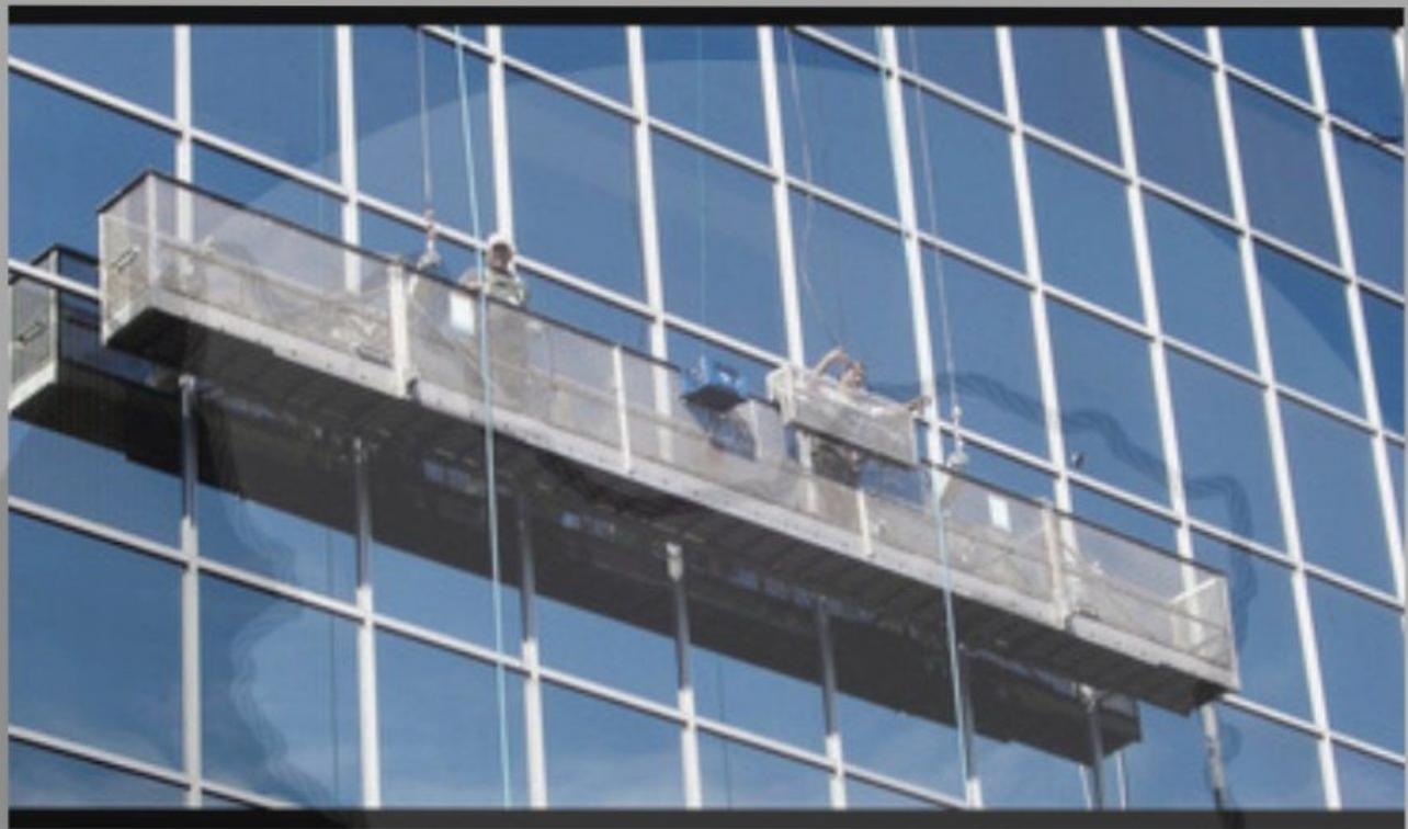
کلایمراه از نقطه نظر حرکتی به دو دسته با حرکت عمودی و با حرکت عمودی - جانبی تقسیم‌بندی می‌شوند. در نوعی از کلایمر با حرکت عمودی، پایه‌های دستگاه در بالای ساختمان قرار می‌گیرد و به وسیله سیم بکسل به موتور وینچی داخل سبد متصل شده و دستگاه را در مسیر عمودی حرکت می‌دهند (این نوع در ایران بیشتر کاربرد دارد)
