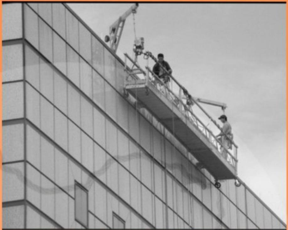
کلایمر ها در واقع نوعی از تجهیزات دسترسی به نمای ساختمان های بلندمرتبه ، سدها ، پلها ، سیلوها ، مخازن نفت و ... بوده که بمنظور تعمیر و نگهداری ، نظافت ، نقاشی ، نصب کامپوزیت پنل و بطورکلی بازسازی و نماسازی سازه های بلندمرتبه که امکان دسترسی به آنها دشوار می باشد طراحی می گردد
